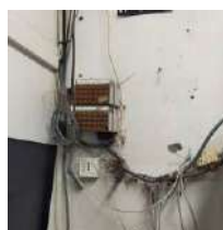
Photo 3 : Sous répartiteur Télécom bâtiment A
