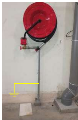
Photo 11 : Mise à la terre d'une canalisation RIA
